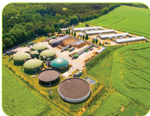
Fig. 7. Centrală cu biogaz din Republica Cehă
