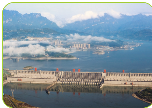
Fig. 3. Barajul celor Trei Defileuri (China)
