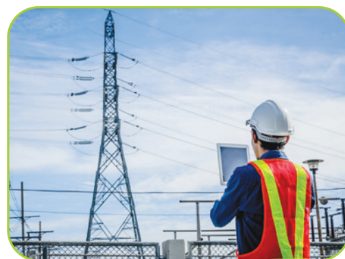
Fig. 9. Stâlp de înaltă tensiune
