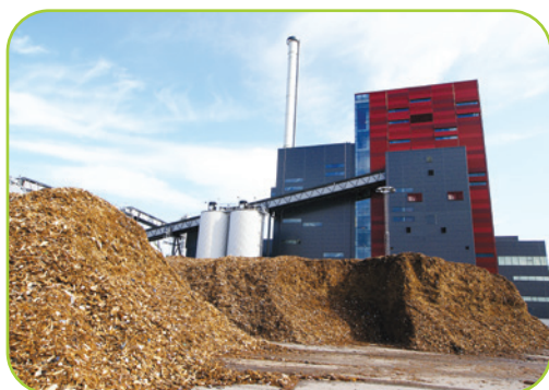
Fig. 8. Centrală care folosește drept combustibil deșeurile rezultate din prelucrarea lemnului
