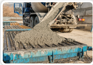
Abb. 7 Herstellung der Grundmauer aus Stahlbeton
